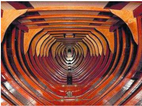
Cuadernas construidas en Lagos. // Astilleros Lagos
